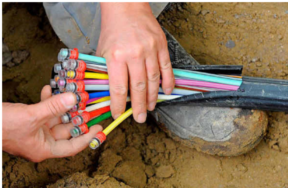
Damit auch bei ihnen bald schnelleres Internet durch die Kabel übertragen wird, haben Bürger in Harpolingen auf eigene Faust gebuddelt und Leerrohre verlegt. FOTO: PETER KNEFFEL/ DPA
